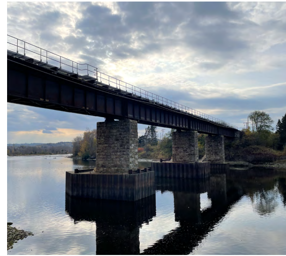
Pont ferroviaire de la rivière Rimouski, 2023 Olivier Beaudin, Ville de Rimouski
