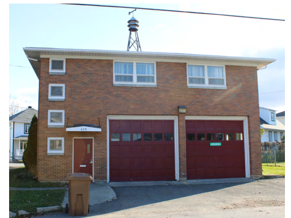
Ancienne caserne de Nazareth 479, rue La Salle (Nazareth), 2023 Tommy Lefebvre, Société rimouskoise du patrimoine
