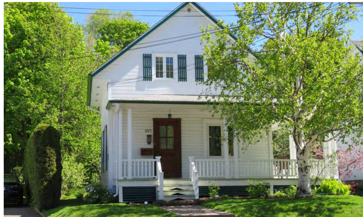
227, rue Saint-Pierre (Saint-Germain) Société rimouskoise du patrimoine
