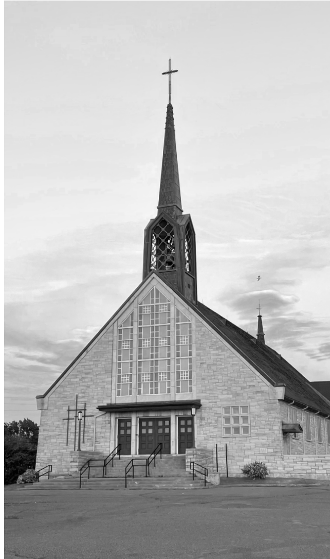
Église Sainte-Agnès avant sa démolition, 2022 Olivier Beaudin
