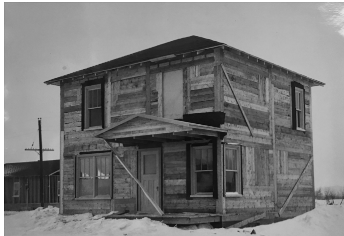
Maison en construction
