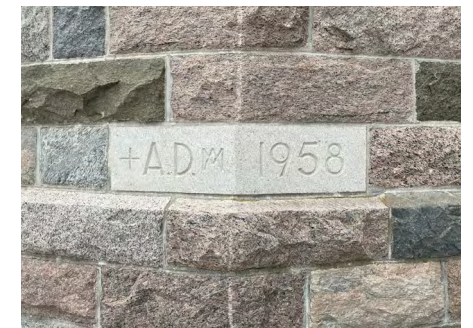
Pierre millésimée indiquant le début de la construction Olivier Beaudin, Ville de Rimouski
