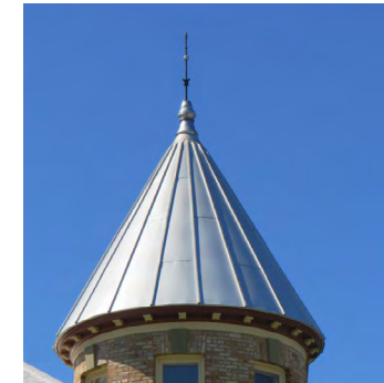
Toiture conique de la tourelle et mât Société rimouskoise du patrimoine
