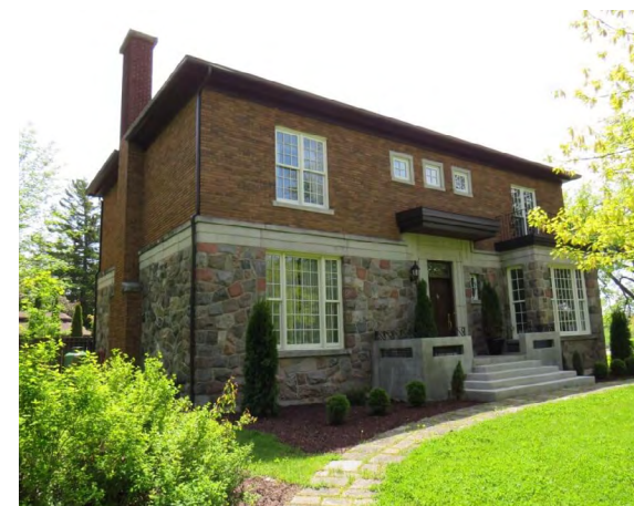
Maison Tessier, 102, boulevard de la Rivière (Saint-Germain) Société rimouskoise du patrimoine
