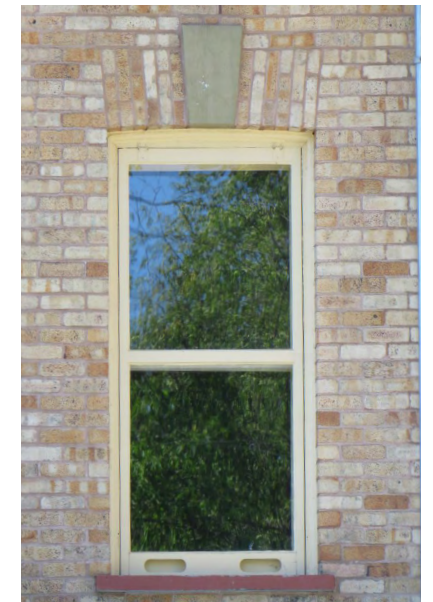
Fenêtre à guillotine et clé de voûte en saillie Société rimouskoise du patrimoine
