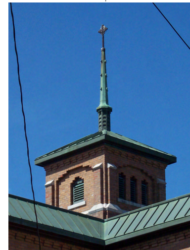
Campanile Société rimouskoise du patrimoine
