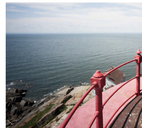
Garde-corps ouvragé, 2014 Patrick Matte
