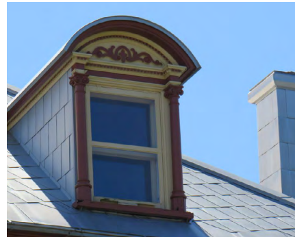
Lucarne à fronton arrondi, pilastres et applique Société rimouskoise du patrimoine
