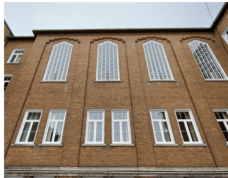
Pilastres, arcs et verrières de la chapelle et de l'aile centrale Olivier Beaudin, Ville de Rimouski
