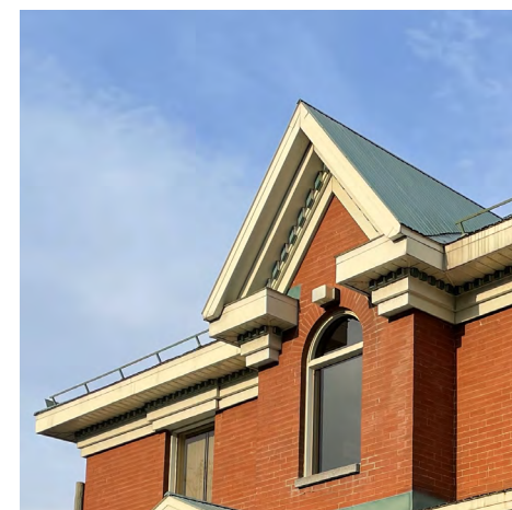
Corniche à modillons, 210-212, avenue Belzile, 2023 Olivier Beaudin, Ville de Rimouski
