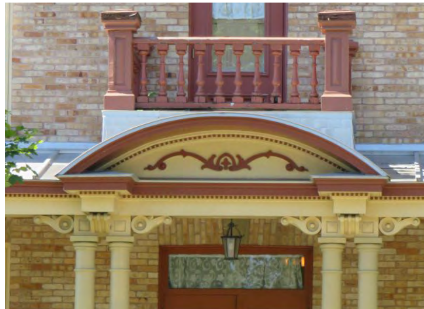
Consoles, fronton arrondi et balcon Société rimouskoise du patrimoine
