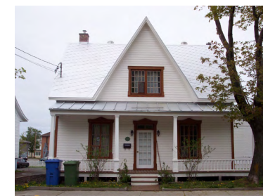
156, rue Saint-Pierre Société rimouskoise du patrimoine
