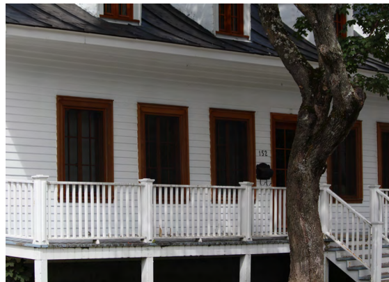
Galerie de la façade sud, maison Pierre-Louis-Gauvreau, 2023 Sandrine Gauthier, Ville de Rimouski
