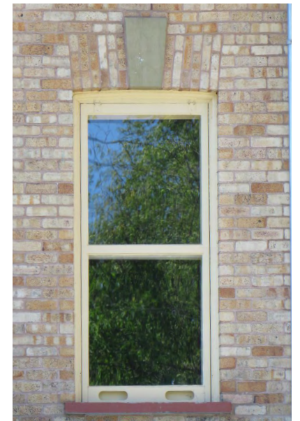
Fenêtre à guillotine et clé de voûte en saillie Société rimouskoise du patrimoine
