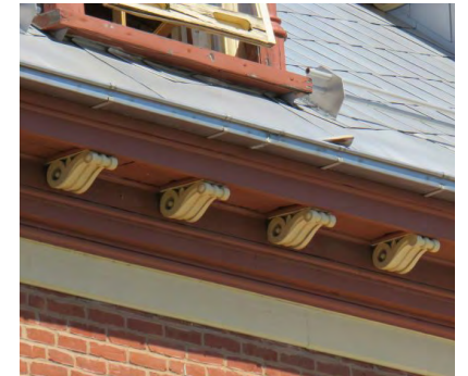
Corniche à consoles Société rimouskoise du patrimoine
