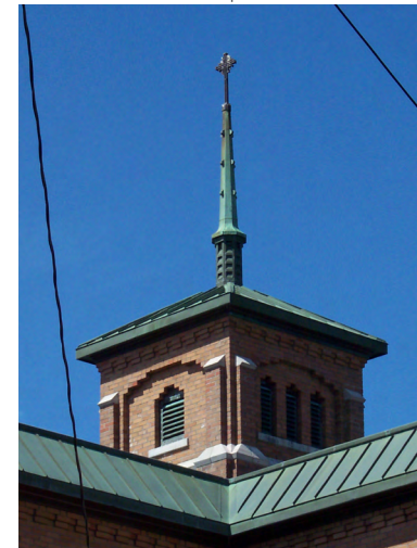
Campanile Société rimouskoise du patrimoine
