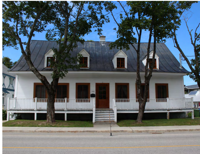
Façade sud, maison Pierre-Louis-Gauvreau, 2023 Sandrine Gauthier, Ville de Rimouski
