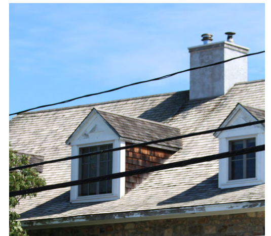
Toiture, lucarnes à pignon droit et cheminée, maison Roy, 2023 Sandrine Gauthier, Ville de Rimouski
