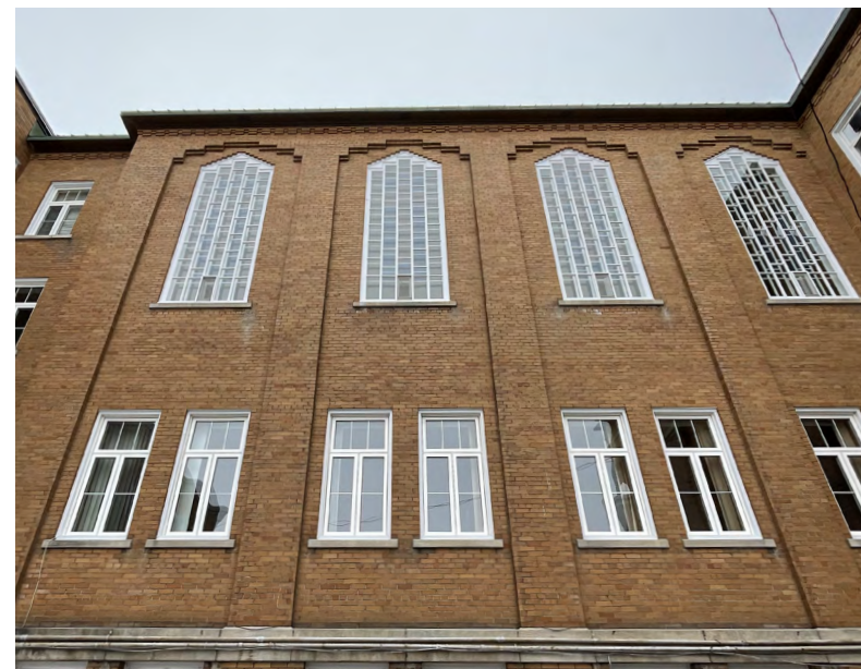
Pilastres, arcs et verrières de la chapelle et de l'aile centrale Olivier Beaudin, Ville de Rimouski
