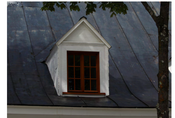
Lucarne à pignon droit, maison Pierre-Louis-Gauvreau, 2023 Sandrine Gauthier, Ville de Rimouski
