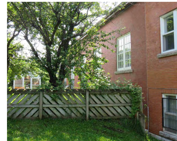
Façade arrière Société rimouskoise du patrimoine
