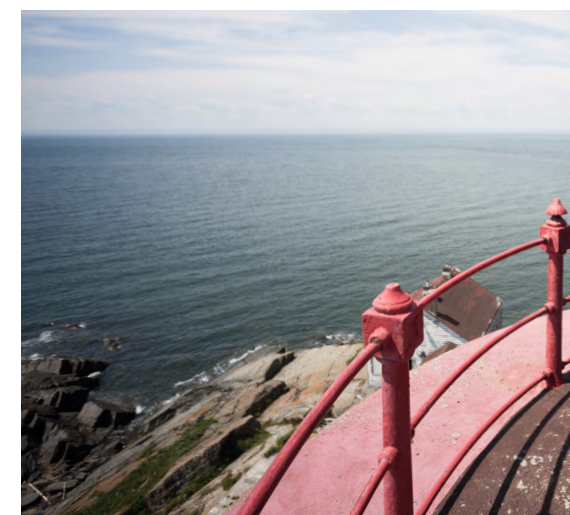
Garde-corps ouvragé, 2014 Patrick Matte
