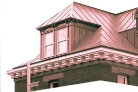
Un toit en tôle à baguettes
