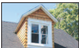
à pignon droit
